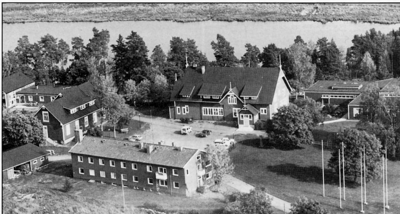
Gårdsplanen dominerades av Bertel Jungs skolkolhus från 1898. Till det ansluter sig Kavaljersflygeln från 1910. Västerut begränsas gårdsplanen av den internatsbyggnad som uppfördes 1960 med Ruben Lindgren som arkitekt. Längst till höger en del av Nya skolan och vänster om Kavaljersflygeln det nya internatet. Byggnaderna blev färdiga 1977. Arkitekt var Carl-Johan Slotte. Sedan fotot togs har gårdsplanen byggts om och blev klar lagom till 100-årsjubileet.
