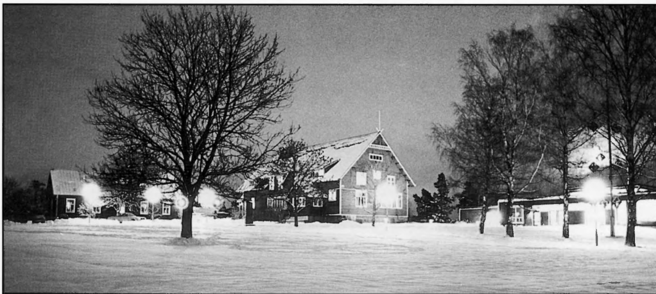
Då renoveringen är klar under vårvintern 1996 ser vi ljus i Kavaljersflygelns fönster igen.
